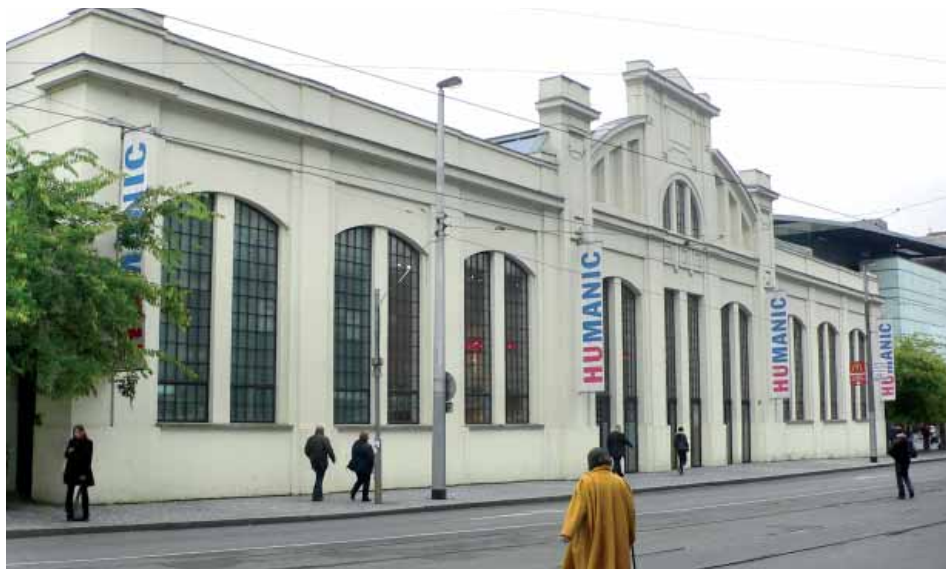
Ze smíchovského areálu zbylo jen průčelí a palác v Kartouzské ulici (snímek dole).
