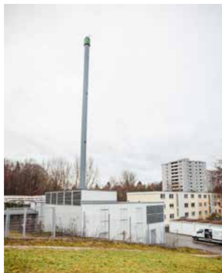
Kogenerační jednotka Caterpillar v Reutlingenu mohla být vybudována v obytné zóně mezi domy, protože neruší hlukem ani zplodinami z komínu.
