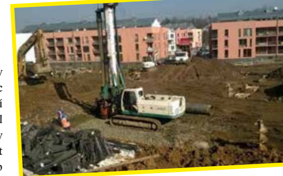
Po udělení stavebního povolení se práce rychle rozeběhly.
