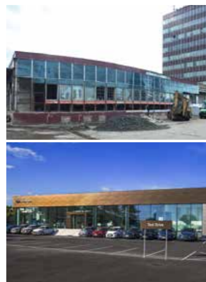
Budova autosalonu před rekonstrukcí a po roce, v době otevření.
