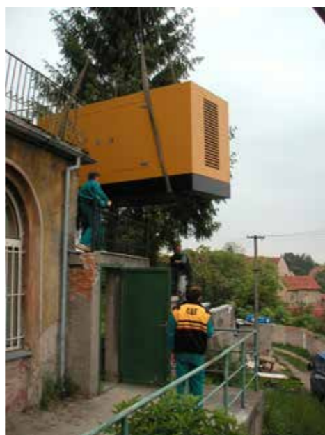
Instalace nouzového zdroje Caterpillar v Domově důchodců v Brandýse nad Labem
