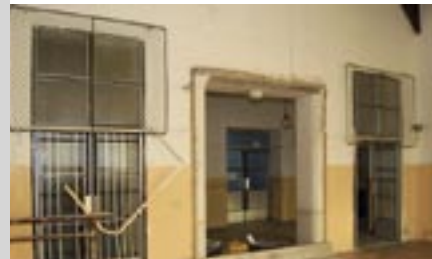
Pohled na původní vchod do tělocvičny, který bude obnoven
