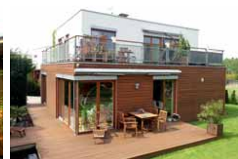
Zateplení fasády – bytový dům v Říčanech
