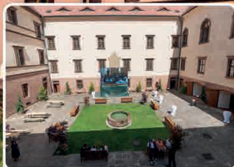
Pohled na nádvoří.
