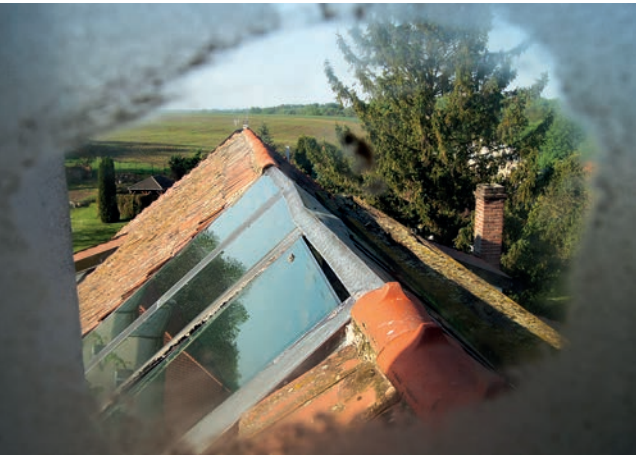
Prosklená část střechy, pohled z věže
