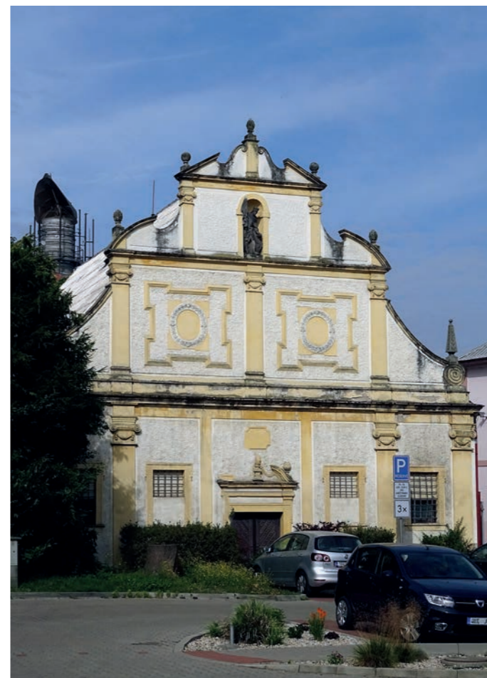
Průčelí sladovny s nikou, ve které je umístěna socha sv. Václava
