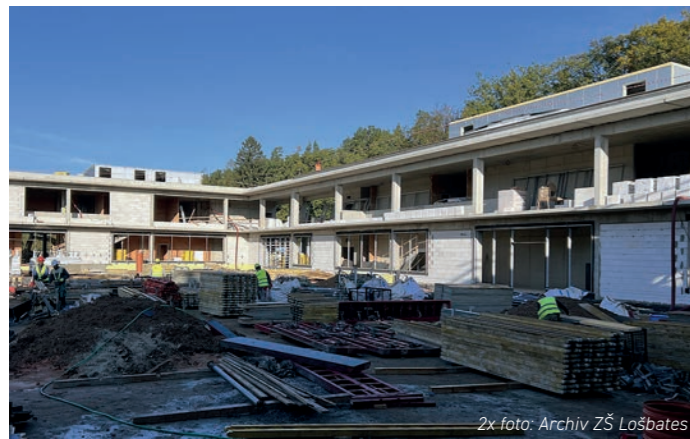
Výstavba základní školy v Louňovicích (foto říjen 2024)
