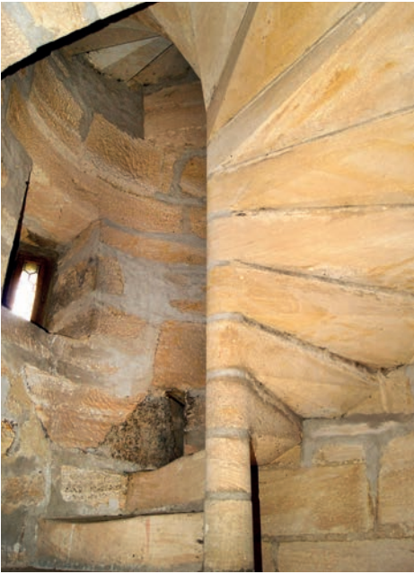
Šnekové schodiště vedoucí do horních pater věže.
