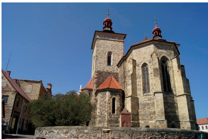
Kostel sv. Štěpána je architektonickou dominantou Kouřimi
