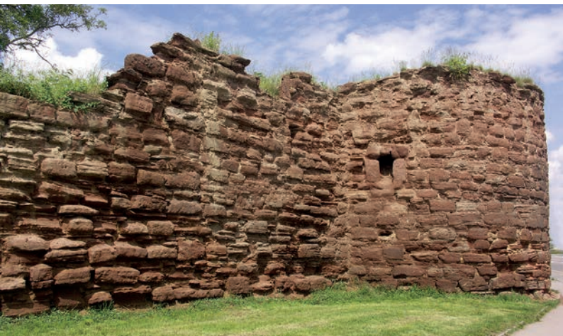
Český Brod: Na konci 15. století bylo dokončeno pozdně gotické městské opevnění. Postaveno bylo z velkých kusů permokarbonského červeného pískovce z lomu na okraji města
