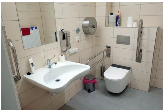
Bezbariérovost, vhodné řešení interiéru a speciální vybavení koupelny a toalet bylo podmínkou rekonstrukce
